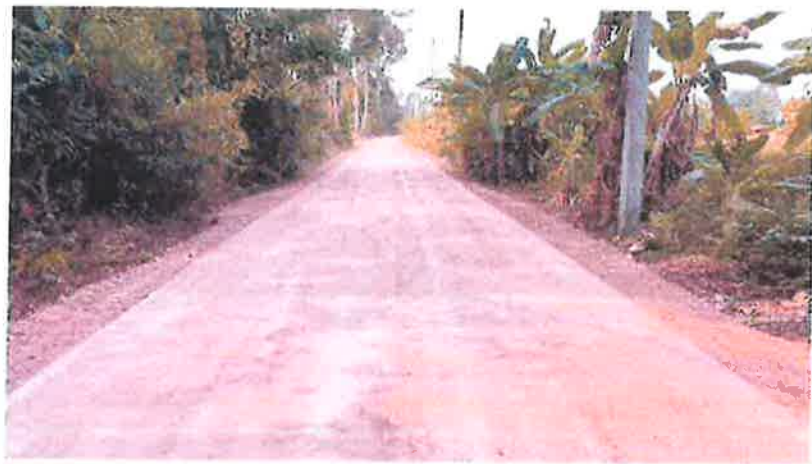
ดำเนินงานเสร็จเรียบร้อยแล้ว
