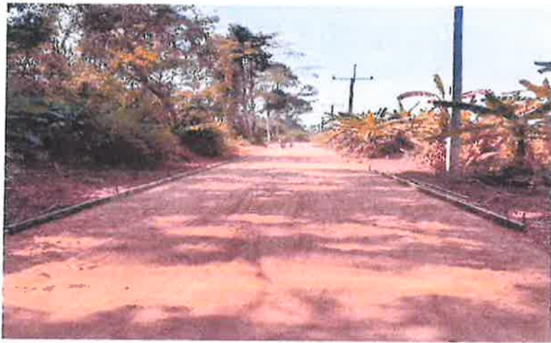
ขณะดำเนินงาน
