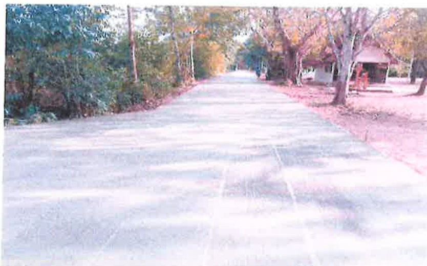
ดำเนินงานเสร็จเรียบร้อยแล้ว
