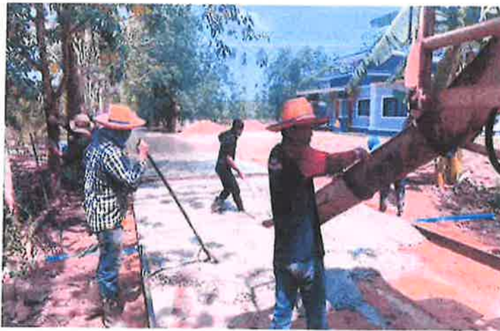
ขณะดำเนินงาน
