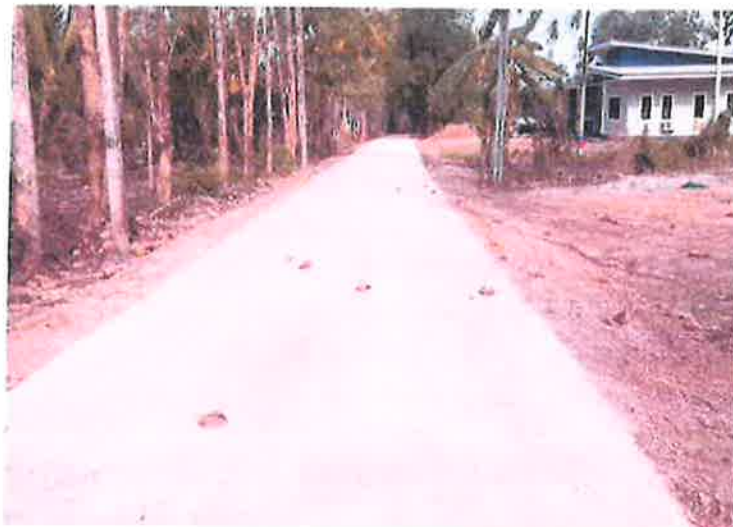
ดำเนินงานเสร็จเรียบร้อยแล้ว
