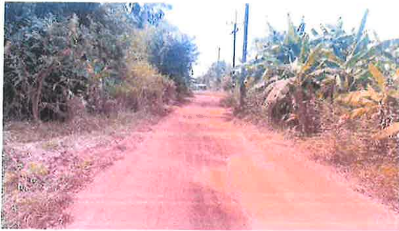
ก่อนดำเนินงาน
