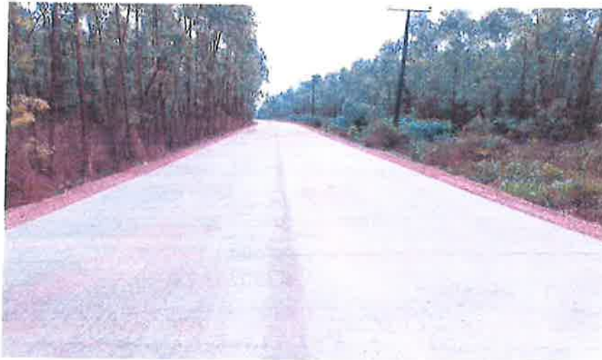
ดำเนินงานเสร็จเรียบร้อยแล้ว
