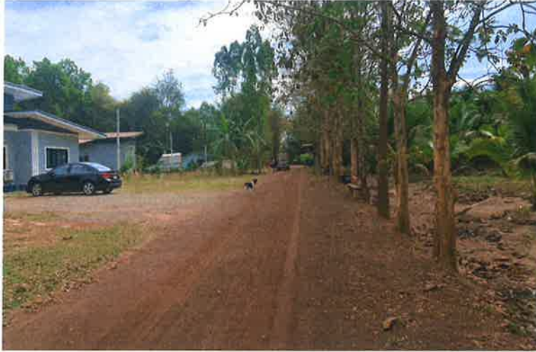
ก่อนดำเนินงาน
