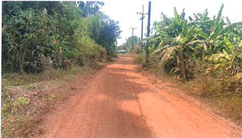
ก่อนดำเนินงาน
