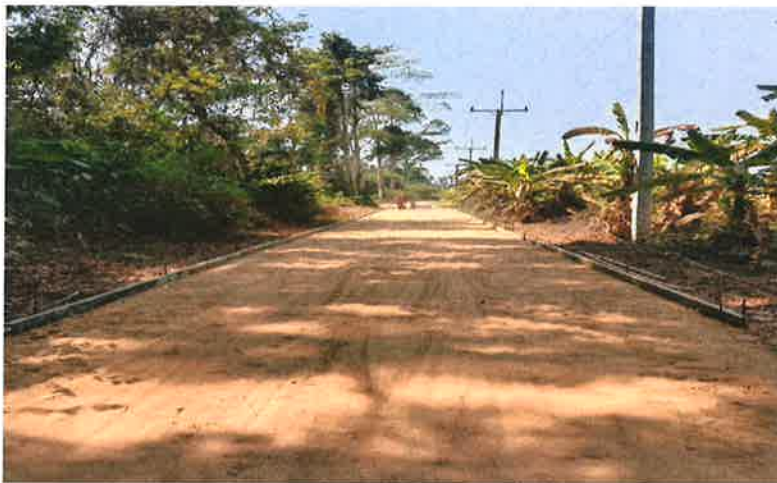
ขณะดำเนินงาน
